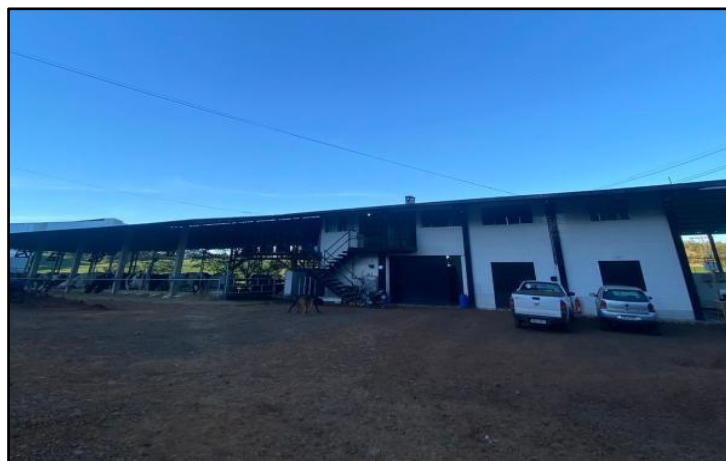
Figura 1: Fachada principal da Fazenda Siqueira, area do barracão.
