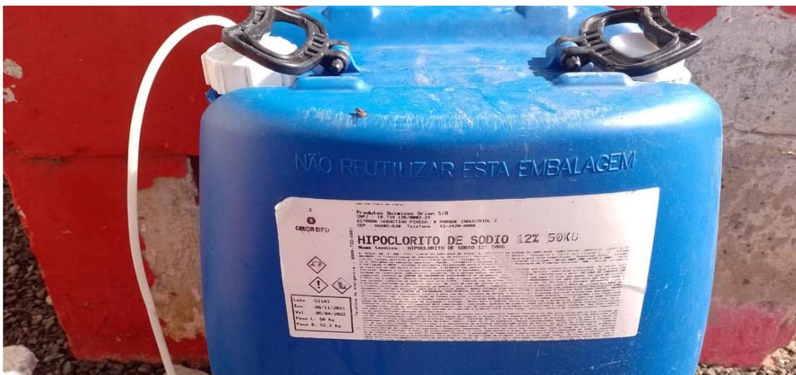
Imagem 08 – Bombona de hipoclorito de sódio 12%, usada na hipercloração da água.
