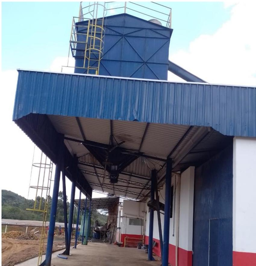
Imagem 21 – Área externa da graxaria onde fica localizada a área de carga, com o silo de farinha em cima.
