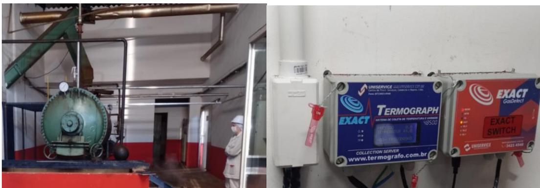
Imagem 10 – Verificação da pressão e temperatura do processo de esterilização.
