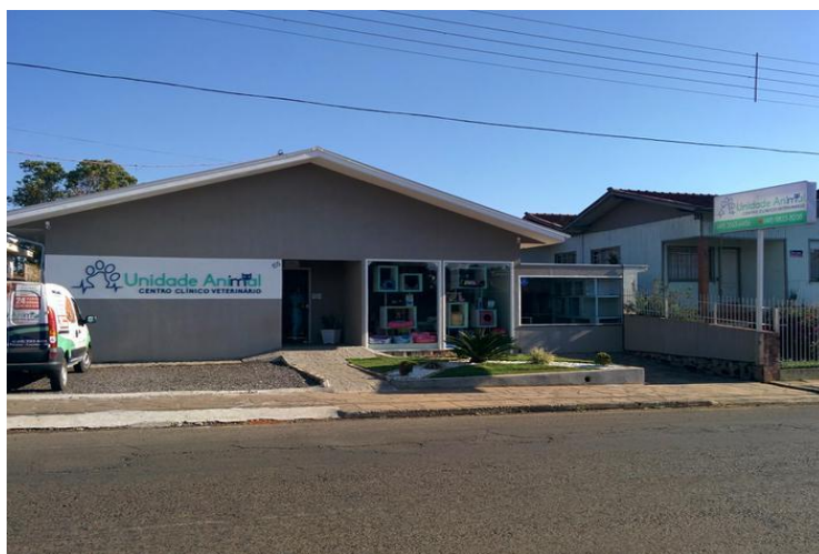
Foto 01 - Fachada da Unidade Animal Centro Clínico Veterinário
